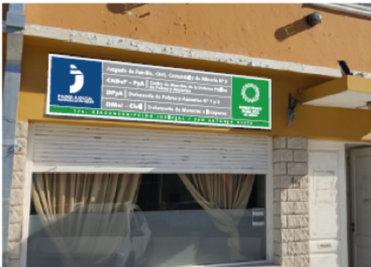
L) JUZGADO CIVIL, DE FAMILIA Y DEFENSORÍAS (Sarmiento 241) Cartel exterior de MDF (fibrofácil) de 60x236 cms., de 20 mm. de espesor, prepintado, con frente cubierto en vinilo impreso full color.
